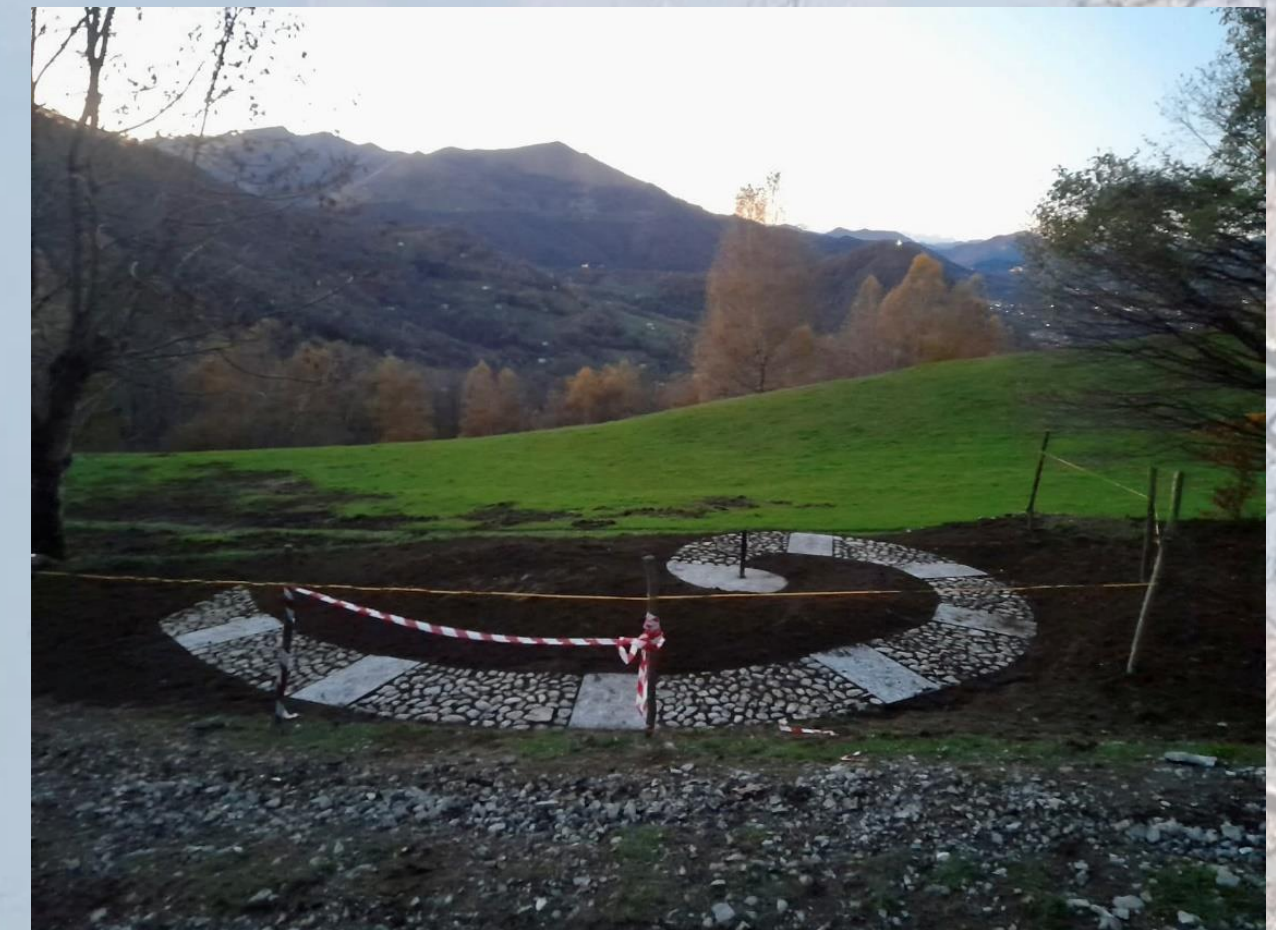
Opera "Cuore" di Simona Bertini ad Alpe Nava, in costruzione (2022)
